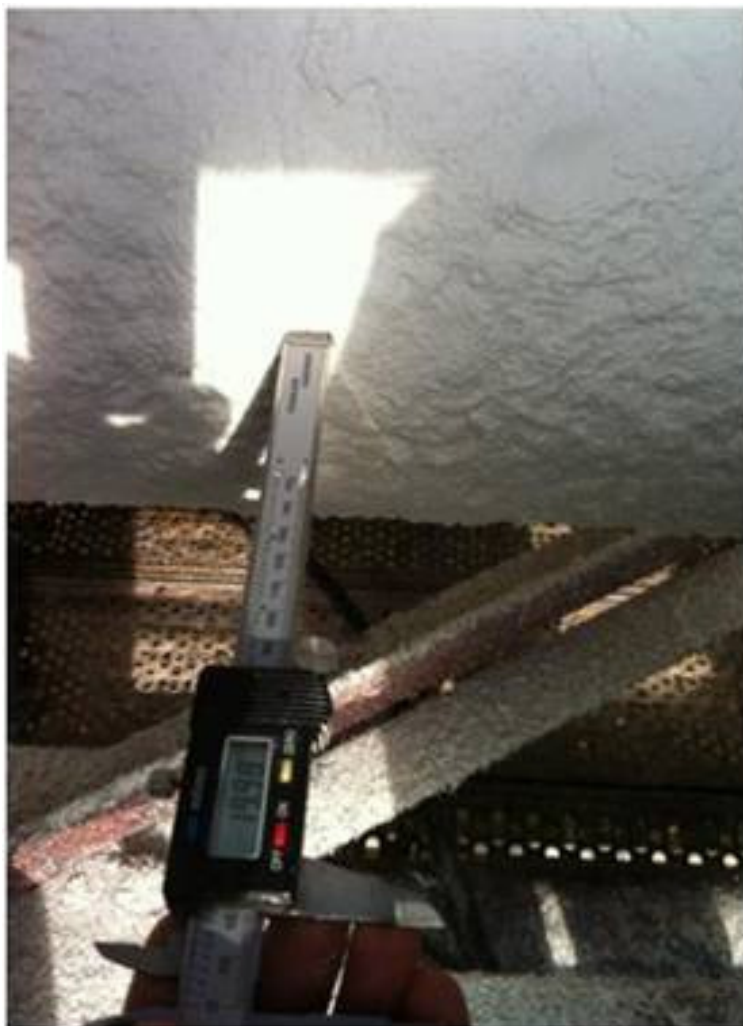
Rysunek nr 2. Pomiar grubości zaaplikowanej powłoki HPC™
