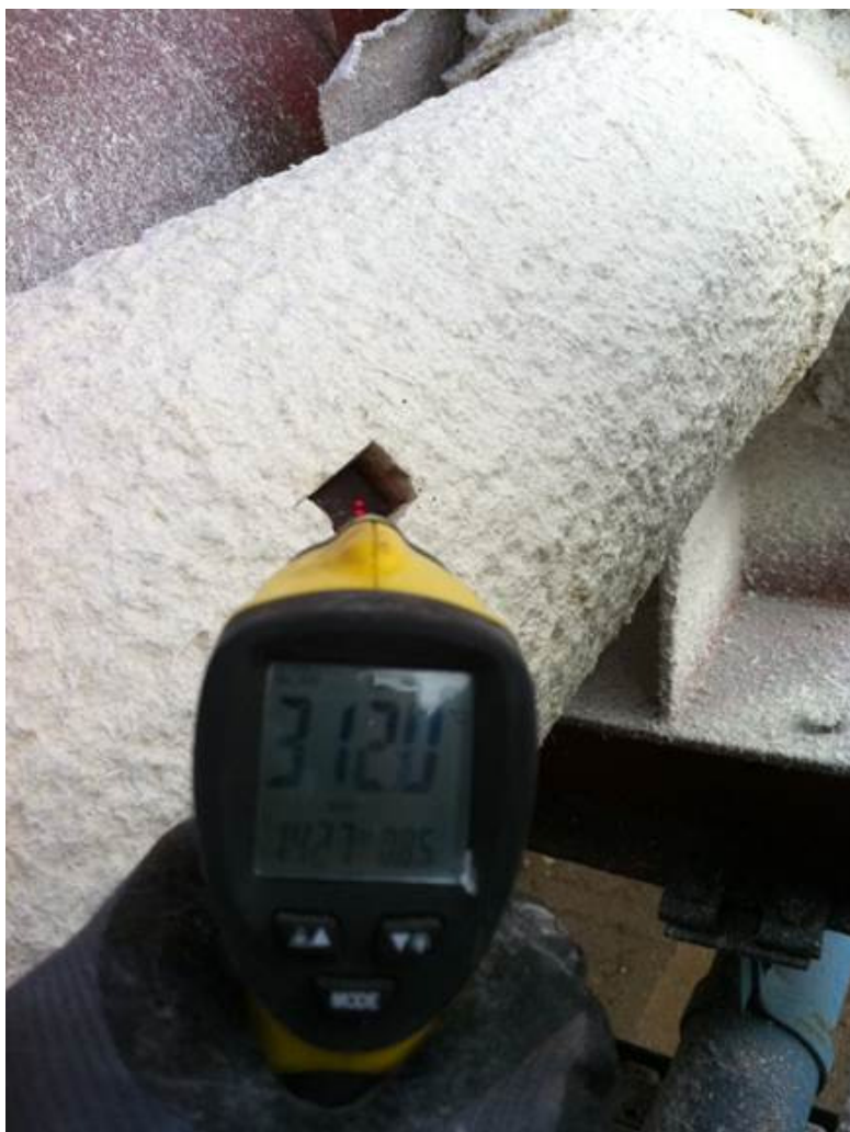
Rysunek nr 4. Pomiar temperatury na powierzchni rury poprzez otwór wycięty w izolacji HPC™
